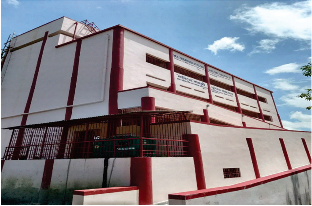
उत्तर 24 परगना जिला में हरिदासकाटी में चक्रवात आश्रय-केंद्र का निर्माण
